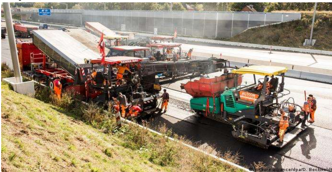
Укладка шумопоглощающего асфальта на автобане А7 в Германии
