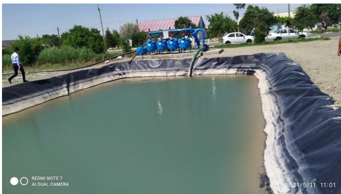
1-расм. “Ислол” фермер хўжалигидаги томчилатиб суғориш тизими.
