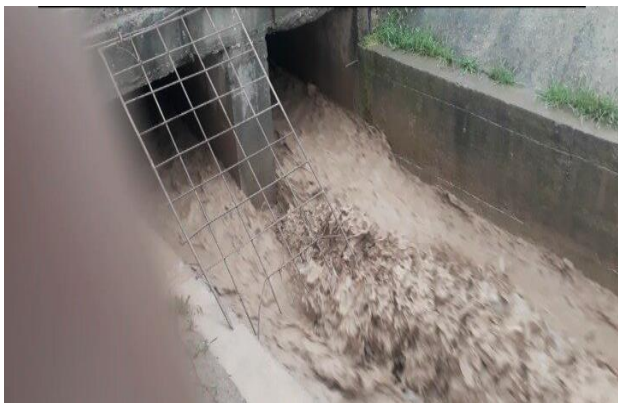
4-расм – Лангар сел-сув омборидан сел-тошқинларни ўтказишдан сўнг сув чиқариш иншоотидаги носозликлар
