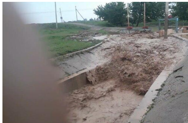
4-расм – Лангар сел-сув омборидан сел-тошқинларни ўтказишдан сўнг сув чиқариш иншоотидаги носозликлар
