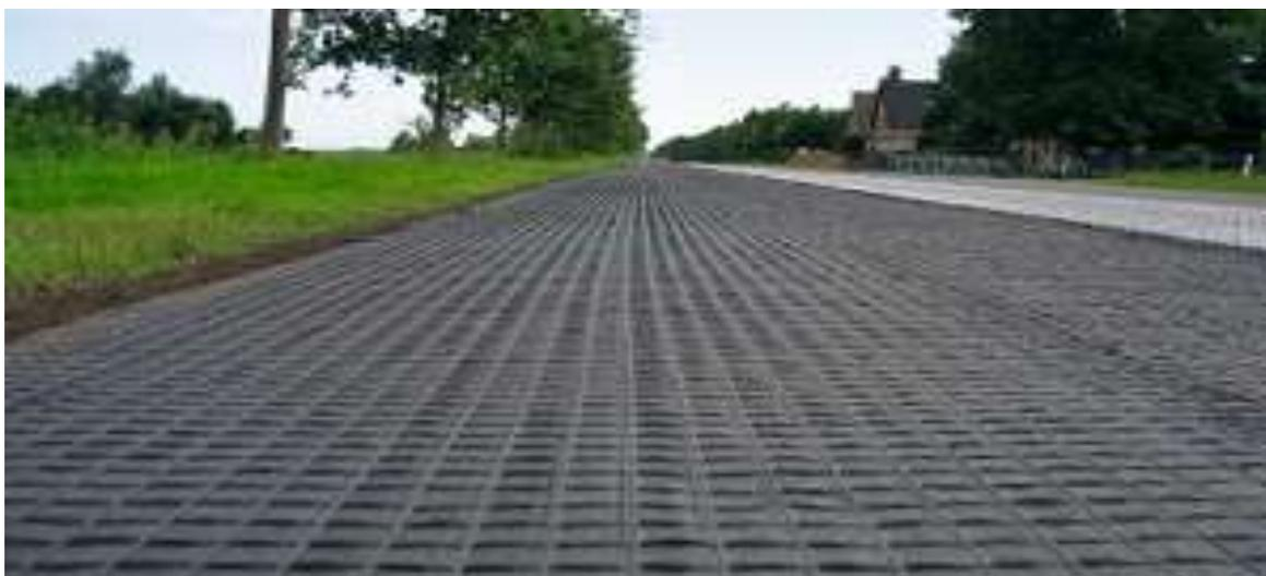
В случаях строительства на слабых основаниях, при наличии переувлажненных связанных грунтов, водонасыщенных песчаных грунтов, рекомендуется в качестве армирующего элемента применять геосетки из базальтволокна выпускаемой в ООО «Базальт» марки СБНП выпускаемые по СТО 5952-004-98214589-2011 в сочетании с разделительной прослойкой из нетканого геосинтетического материала.
