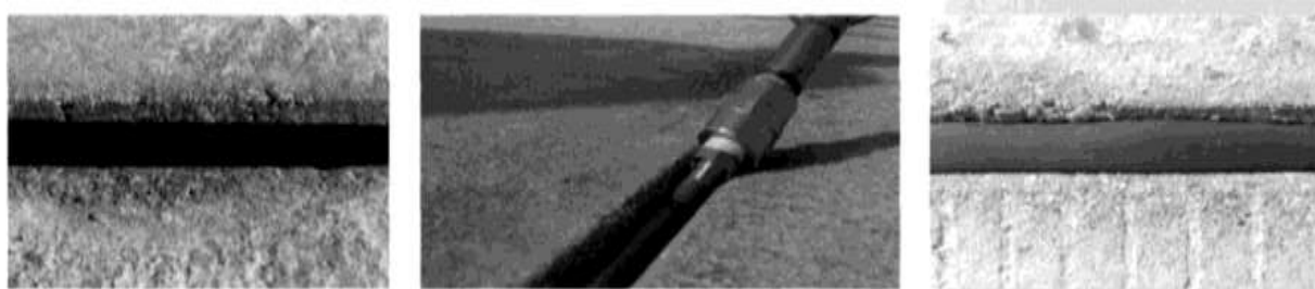
1-rasm. Sementbeton qoplamali choklarni germetizatsiyasining ko'rinishi
