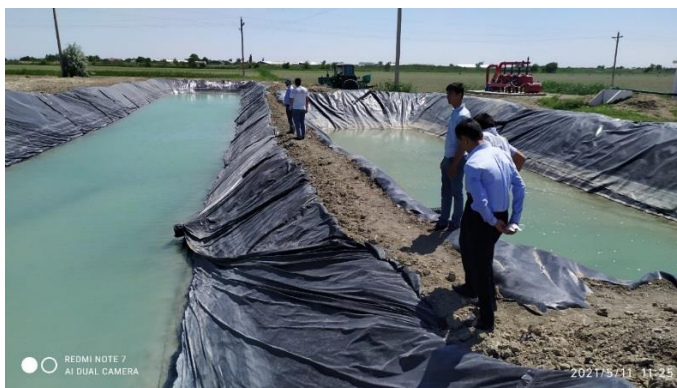
4-расм. “Адизобод Эркин Махмуд” фермер хўжалигидаги томчилатиб суғориш тизимидаги мимбрнали тиндиргич.
